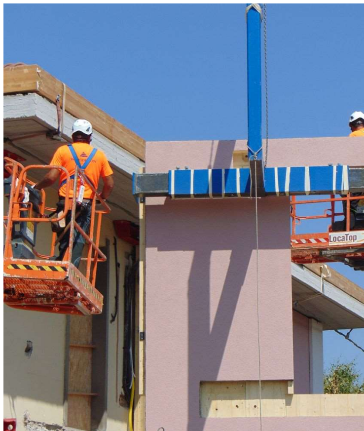
Gli operai in quota mentre avvicinano il pannello alla facciata esistente
