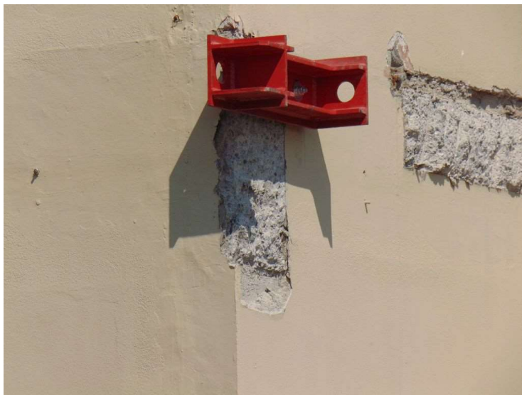
Gli ancoraggi in acciaio per il fissaggio del pannello
