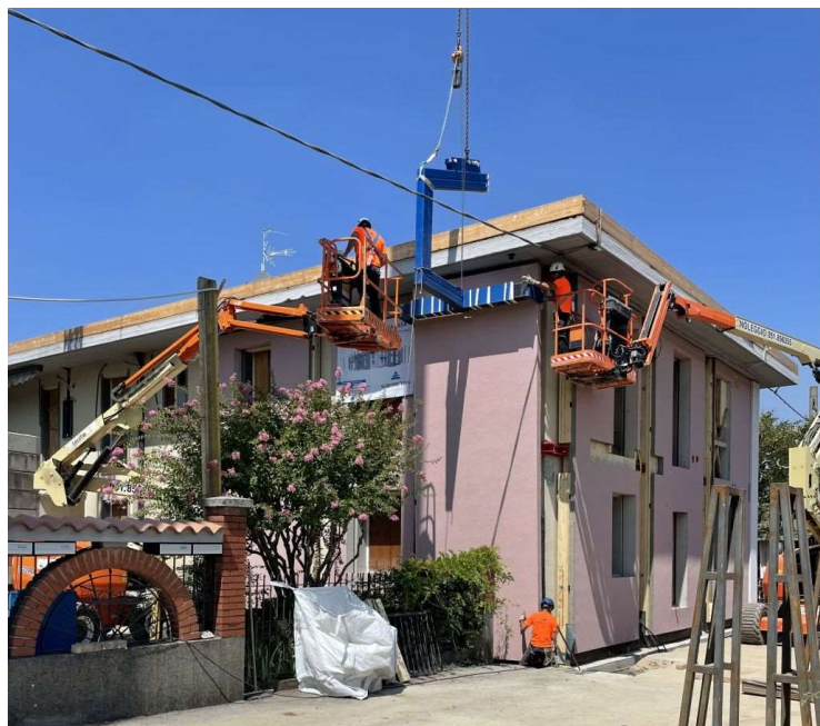
L'edificio a due piani di Corte Franca sottoposto a intervento di riqualificazione energetica e adeguamento sismico
