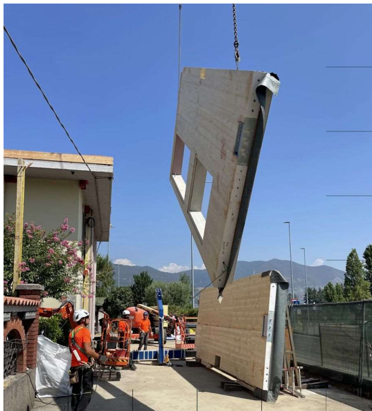
L'operazione di sollevamento di uno dei pannelli di facciata da posare
