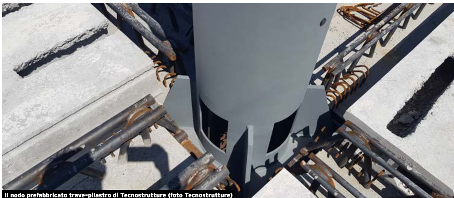
Il nodo prefabbricato trave-pilastro di Tecnostrutture (foto Tecnostrutture)
