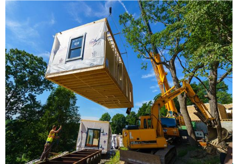
Edilizia Temporanea modulare (ET)
