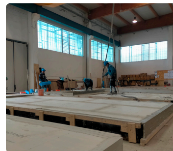
Via Russoli, Milano: finitura in fabbrica dei pannelli prefabbricati. Foto: Beatrice Arenella.
