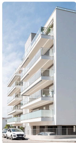
Tuna Palace, Udine (2015): residenze su otto piani con struttura prefabbricata in legno. Foto: Wolf Haus.
