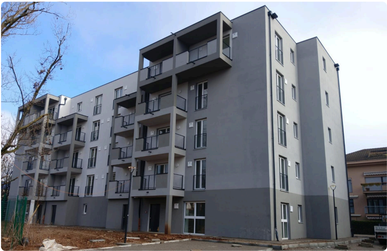
Edilizia residenziale pubblica realizzata con un sistema prefabbricato: 28 alloggi ALER a Monza. Foto: Wolf Haus.
