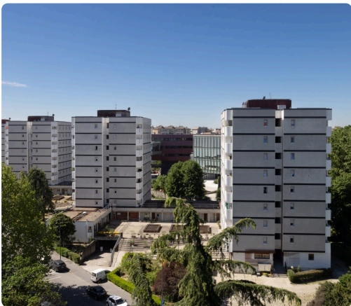
Torri di edilizia pubblica di via Russoli, Milano, riqualficate con facciate prefabbricate. Foto: EnergieSprong Italia.
