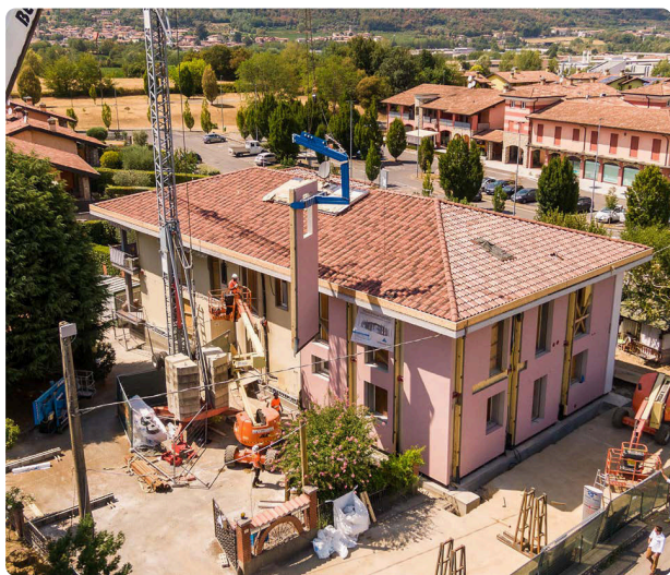
Montaggio di facciate prefabbricate in un cantiere di riqualificazione EnergieSprong. Foto: EnergieSprong Italia, «Interventi» (2025).
