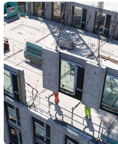
Moduli tridimensionali prefabbricati posati in cantiere per un nuovo edificio residenziale. Produttore e foto: FP McCann, fpmccann.co.uk.
