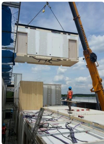
Montaggio di moduli tridimensionali prefabbricati in cantiere. Foto: WB Factory.
